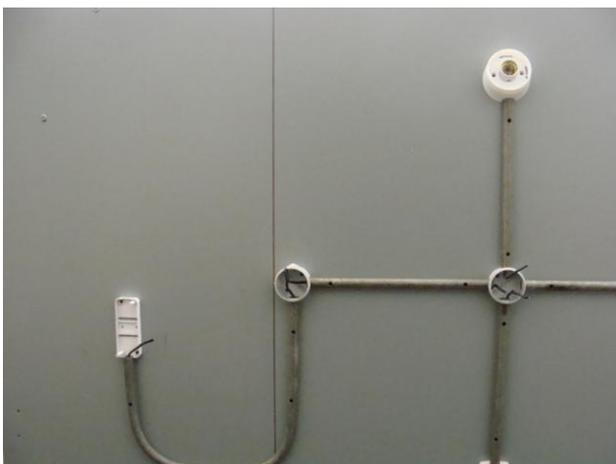
Протащить провода в трубах
