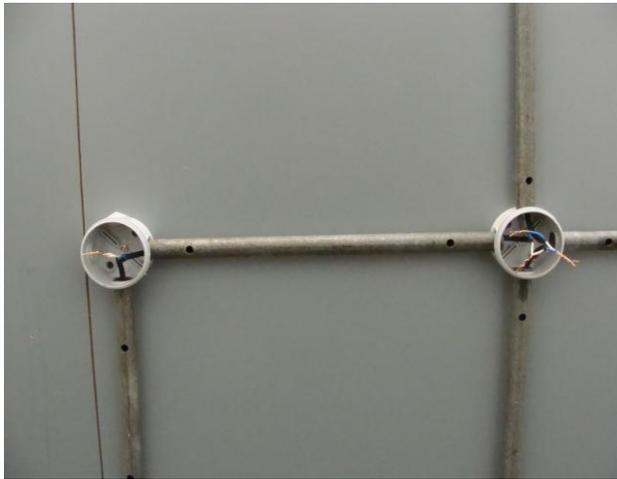
Соединить концы проводов в монтажных коробках с помощью плоскогубцев
