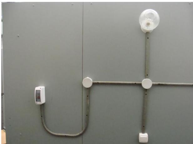
Подключить концы проводов к розетке, выключателю, патрону лампы, автоматическому выключателю
